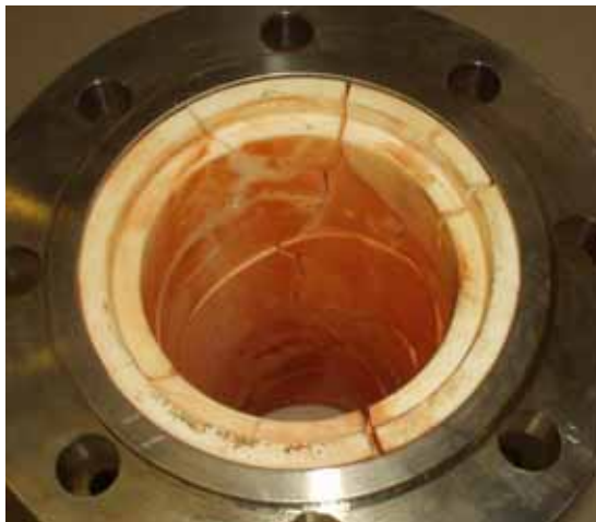
Bild 3: Auskleidung nach Thermoschockbelastung
