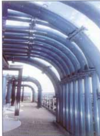
Bild 7: Siloanlage mit pneumatischer Befüllung
