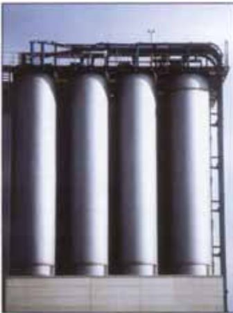
Bild 7: Siloanlage mit pneumatischer Befüllung
