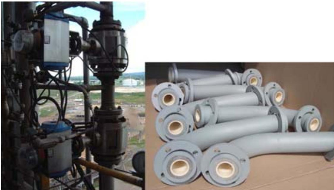
**Bild 18 / 19:** Keramikarmaturen und Rohrbögen Stahlwerk Trinidad
