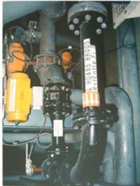
**Keramische Rohrbögen und Kugelhähne
