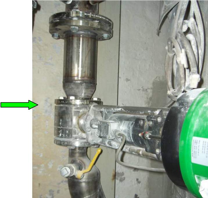
Bild 68: Keramischer Scheibenschieber in Kombination mit einer Festdrossel
