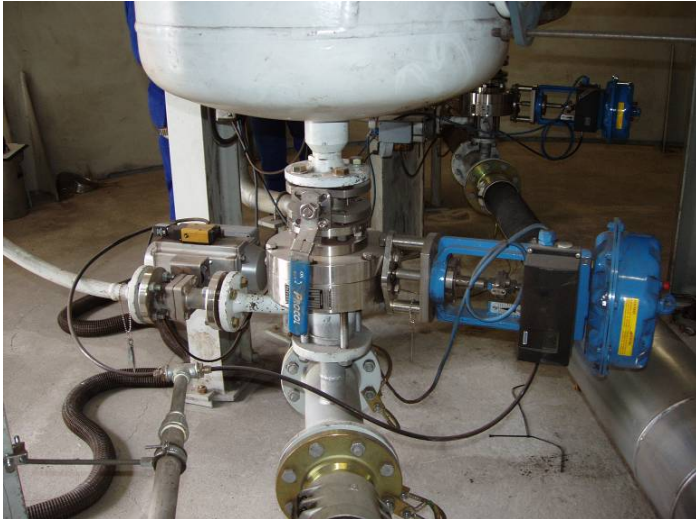
Bild 16: Ausschleusearmatur unter Sendegefäß
