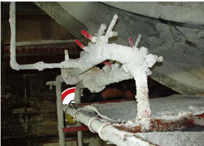
Bild 31: Rohrleitung „eingesalzt“
