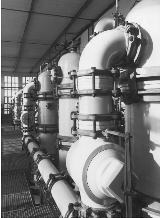
Bild 3: Küchenhahn in keramischer Chemieanlage
