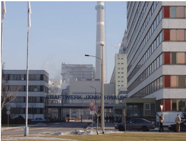
Bild 6: KW Jänschwalde, Haupteingang
