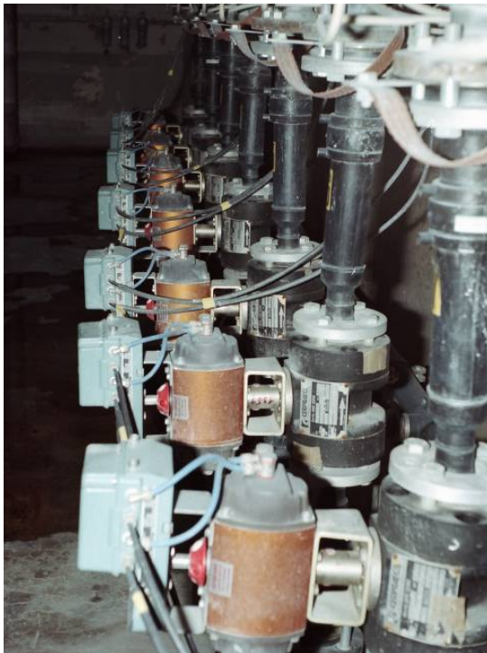
Bild 23: Regelstrecke mit keramischen KH
