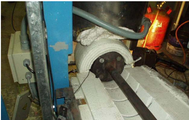
Bild 66: Flüssigmetallkugelhahn in der Anlage
