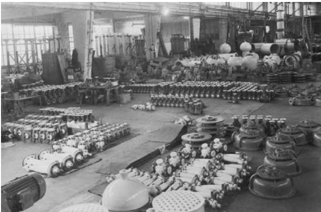
Bild 1: Fertigung von Chemikeramik
