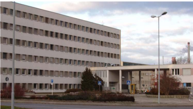
Bild 39: PCH Schwedt, Hauteinfahrt
